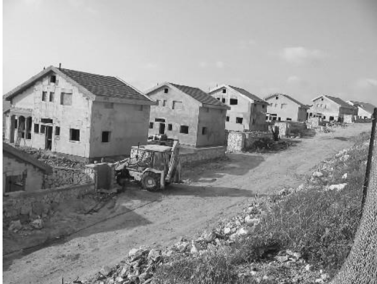
Casas nuevas que se construyen en el asentamiento israelí de Revava en tierras palestinas confiscadas en los cercanos pueblos de Hares y Deir Ballut, Cisjordania © Anna Baltzer
