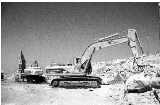
Una excavadora israelí destruye tierras palestinas en Cisjordania para hacer sitio a la valla/muro © AI
